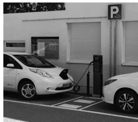
Punt de recàrrega elèctrica davant el Centre Cívic.
